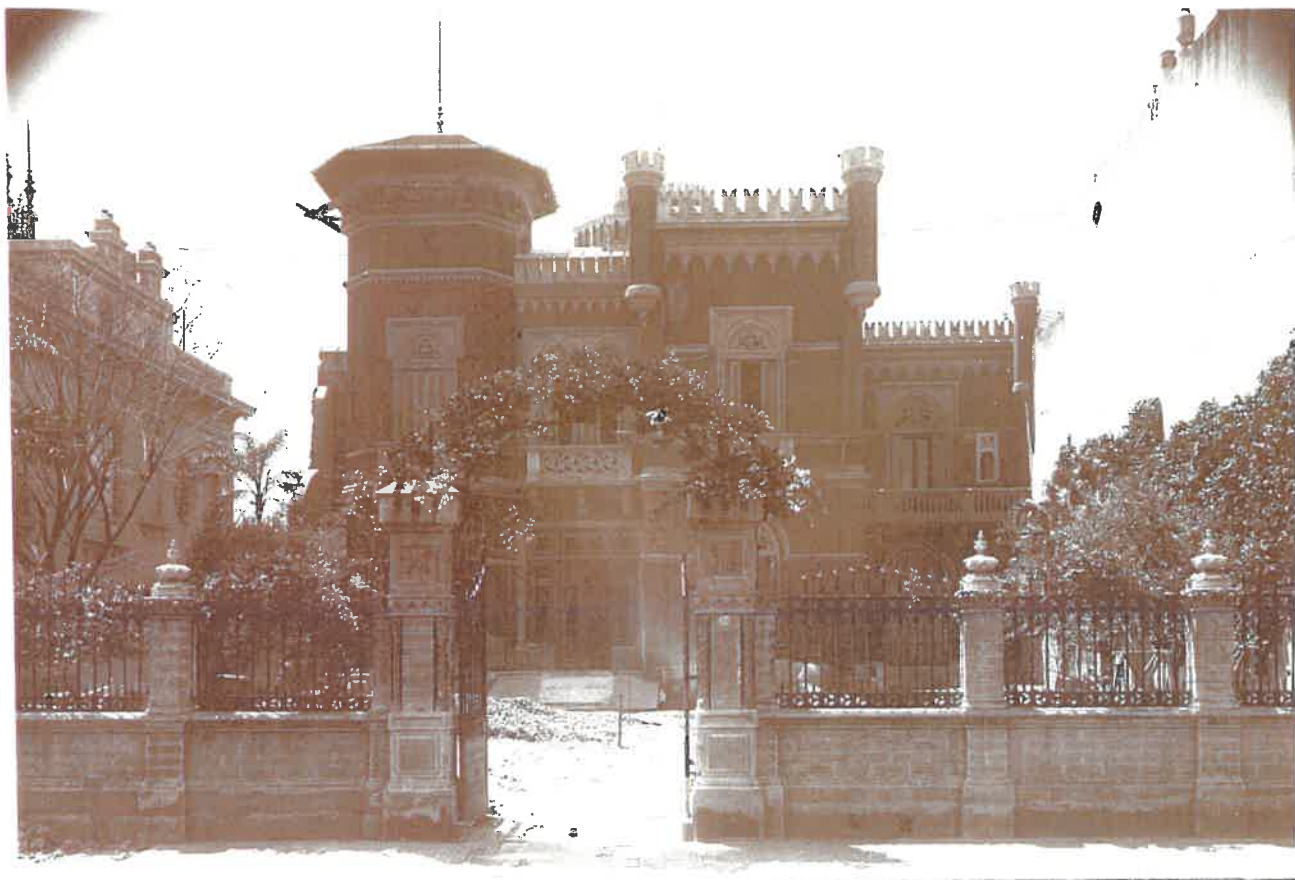
La casa de Av. Alvear 1531, en plenos arreglos de pintura y jardín. A la izquierda se ve la casa de Silvestre Blaquier. A la derecha el paredón de la casa de Pablo Cárdenas. Qué linda verja !
